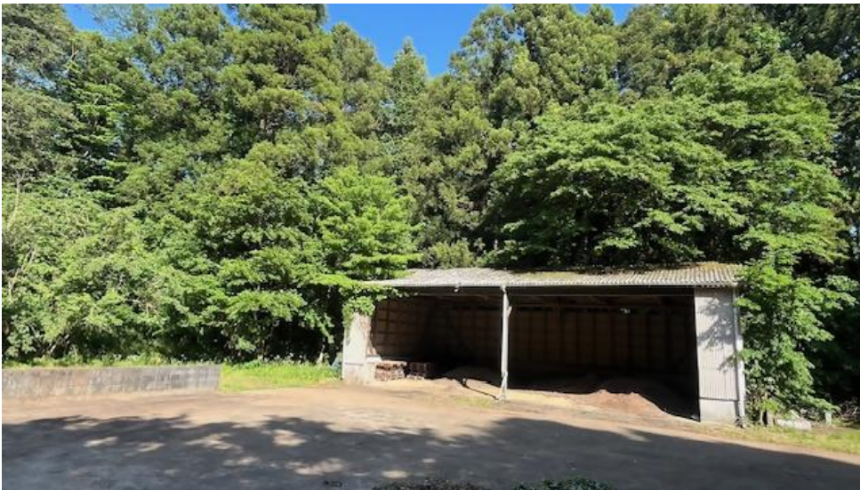
G コンクリート敷きのスペース（※生産物残渣置き場）
