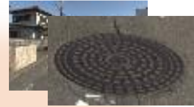
②マンホール蓋画像抽出 (全景及び拡大)
