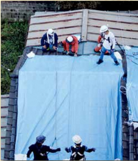
専門事業者と市消防局によるブルーシート張り (房総半島台風)
