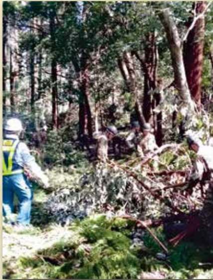
自衛隊と建設業協会による道路啓開 (房総半島台風)
