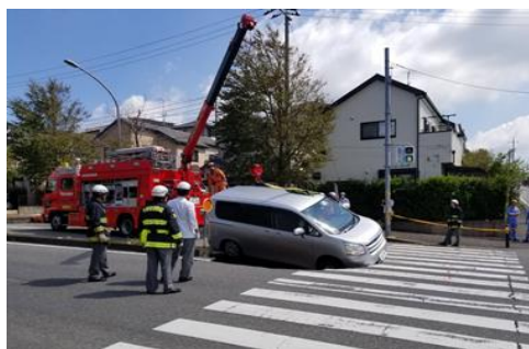
令和元年 老朽化した管渠の損傷による道路陥没事故（緑区あすみが丘）
