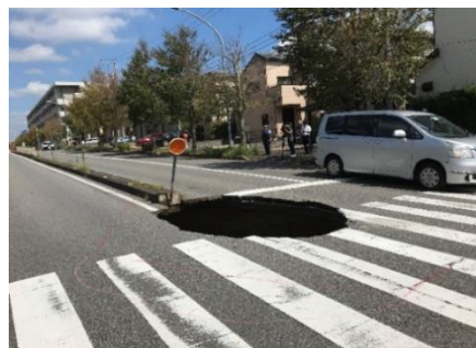
令和元年 老朽化した管渠の損傷による道路陥没事故（緑区あすみが丘）
