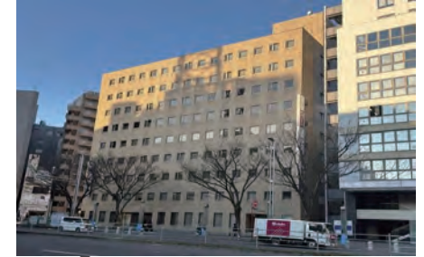
朝日生命千葉ビル
