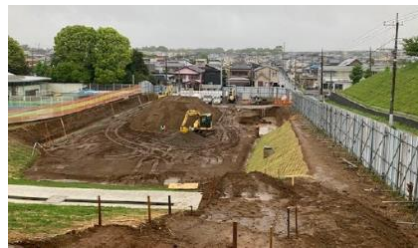
公園復旧工事の様子(R8.4)
