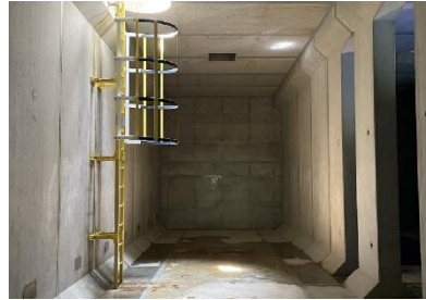
貯留槽内の様子(R6.3)
