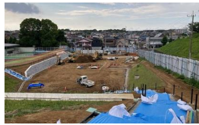
公園復旧工事の様子(R8.6)
