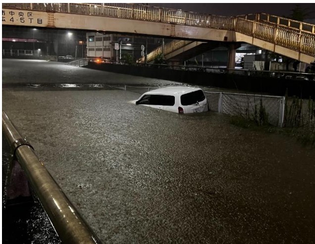
アンダーパスの浸水
