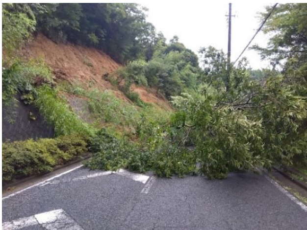
斜面の崩落
