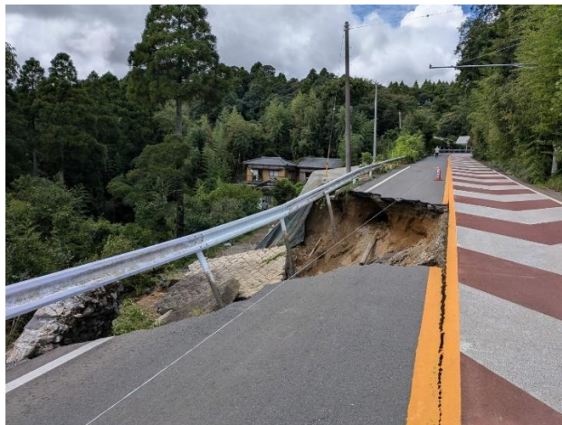
斜面の崩落
