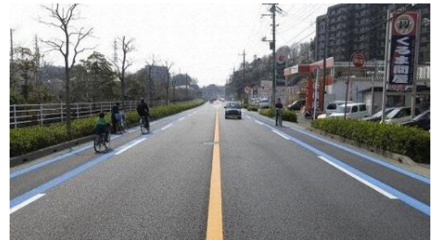
自転車走行環境整備現況 (自転車通行帯)
