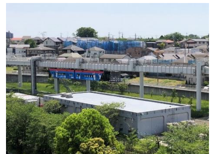
回生電力貯蔵装置が導入された殿台変電所
