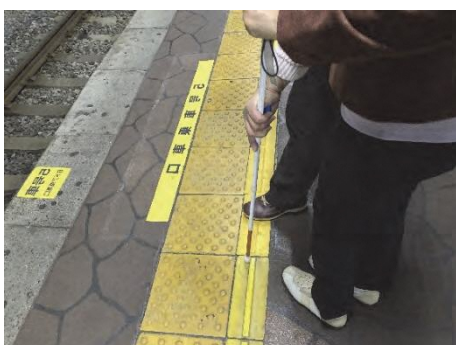
図 4-4 内方線付点状ブロック
