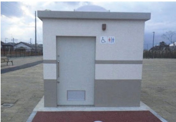
図 4-1 2 ユニットトイレ（園生三和公園）
