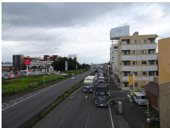
国道357号(蘇我副都心付近)
