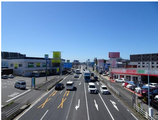
国道16号(長沼町付近)
