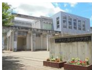
小学校改修工事
