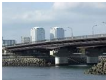
橋の長寿命化工事
