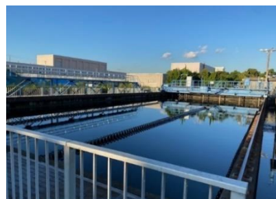
浄化センター整備事業
