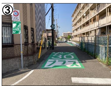
ゾーン30プラス看板・路面表示
