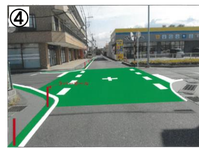
交差点部カラー舗装、路肩のカラー化
