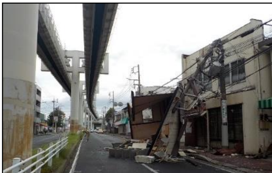
R 元 台風 15 号による電柱倒壊状況
