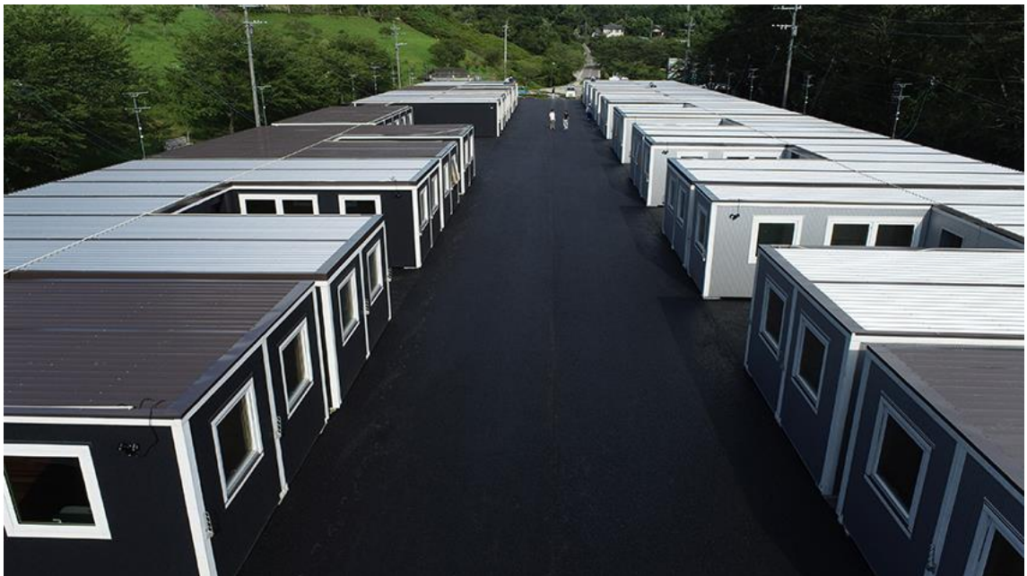
事例（令和２年７月３日からの大雨による災害）
