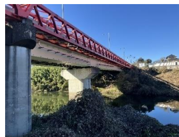
天戸大橋(花見川区天戸町)
