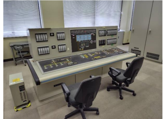
監視制御設備（大木戸浄水場）
