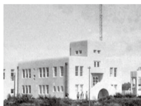
竣工時の写真
