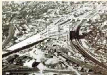
移転工事中の千葉駅
