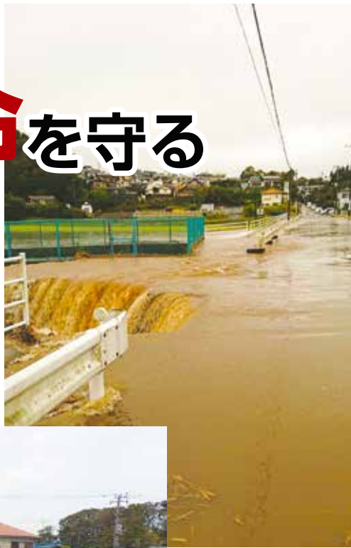
10月25日の大雨による冠水（若葉区川井町）▶
