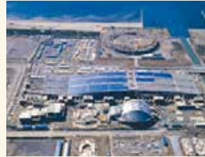
建設中の幕張メッセ
