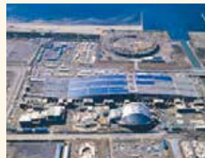
建設中の幕張メッセ
