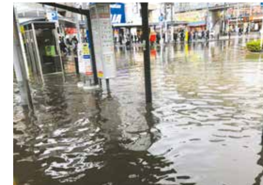
▲2019年10月25日大雨による冠水(蘇我駅前)
