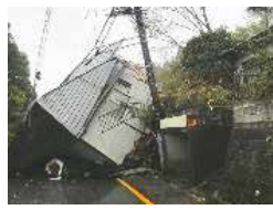
台風・大雨による被害
