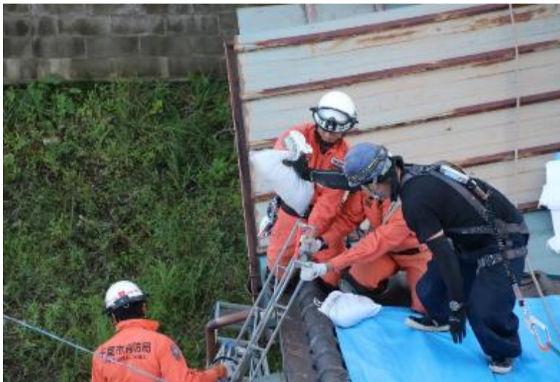
市外から駆け付けた建設会社による ブルーシート張り
