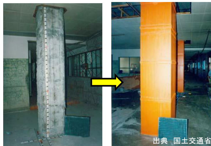
改修事例(柱に鋼板を巻き立て)
