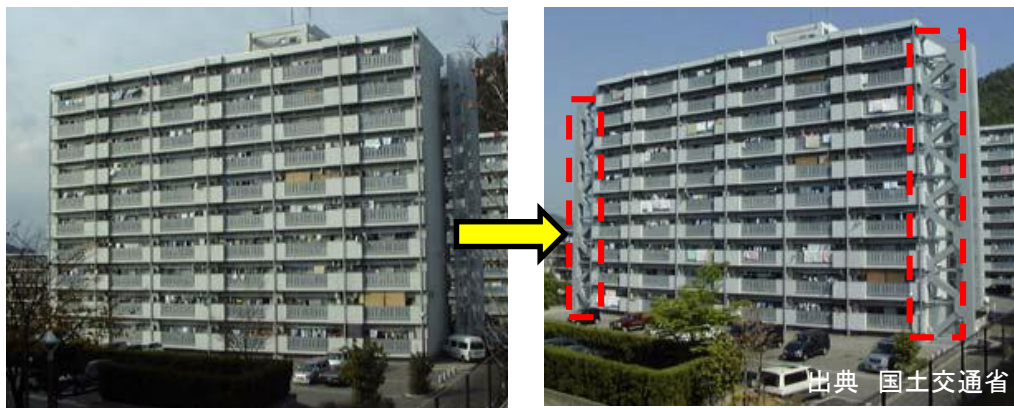
改修事例(外壁にフレーム追加)
