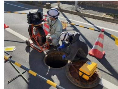
緊急点検の様子
