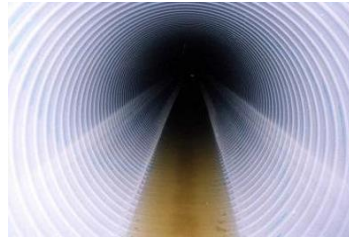
内側に帯状のプラスチックを 巻き立て修理した下水道管 (2、3)
