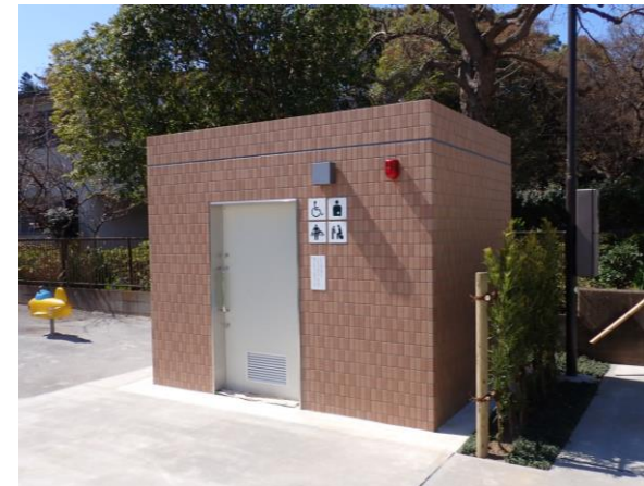
改修後の公園トイレ
