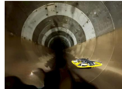
ドローン点検の様子
