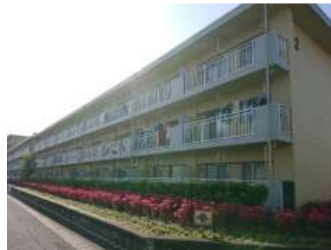
市営住宅（小倉台団地）
