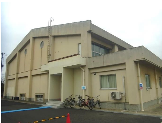
既存体育館を活用
