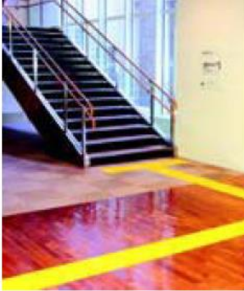
床の素材を変え、歩行感により空間を認識しやすくする (千葉市：ハーモニープラザ)
