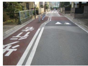
図 37 歩道のない道路での安全対策（路側帯のカラー舗装）
