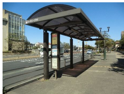
図 20 バリアフリー化された停留所
