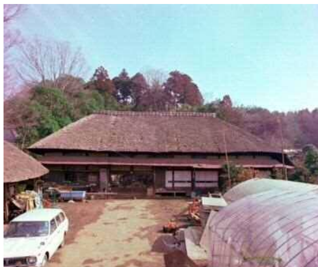
旧四関家（解体保存中）
