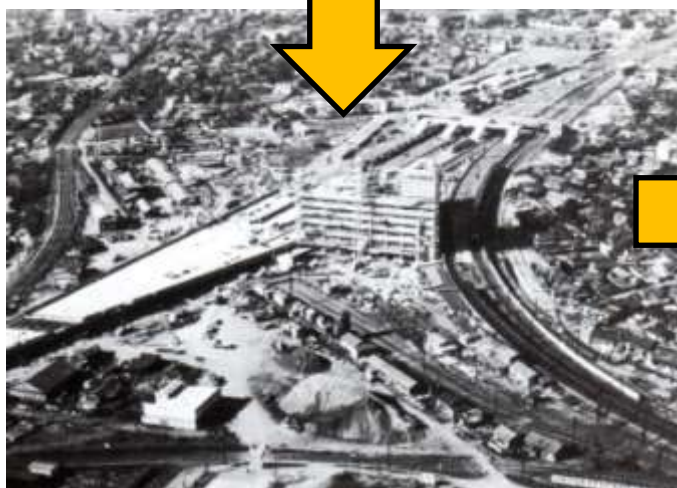
移転工事中(S38年開業)
