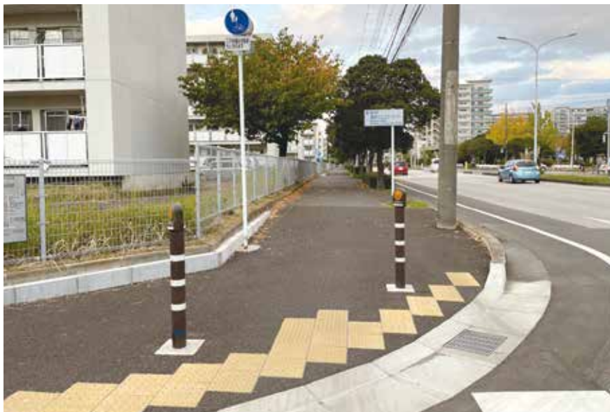
バリアフリーの推進（歩道段差解消）
