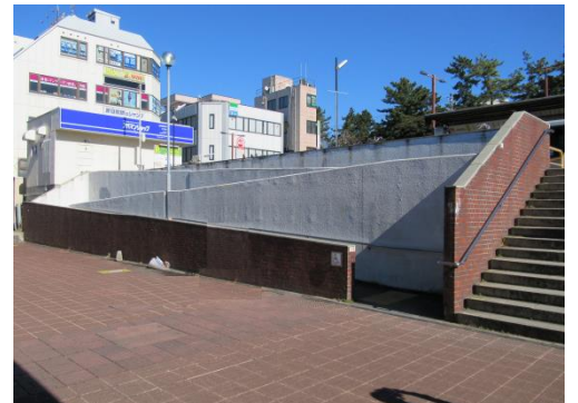
設置予定箇所（JR西千葉駅北口）
