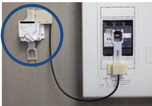
感震ブレーカー簡易タイプ（ばね式）
