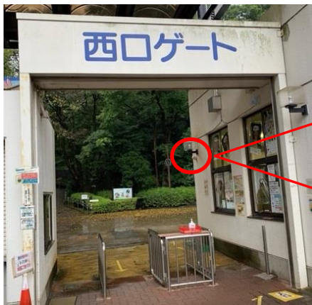
西口ゲートのカメラ設置場所
