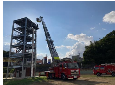
新たに完成した訓練塔（高層棟）
