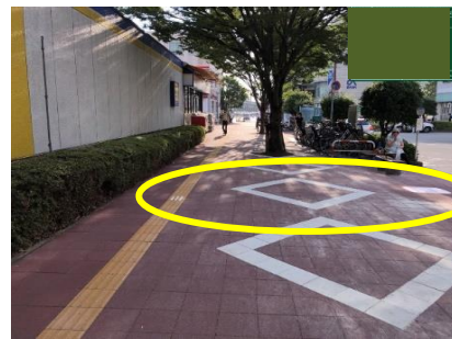
本工事完了後
