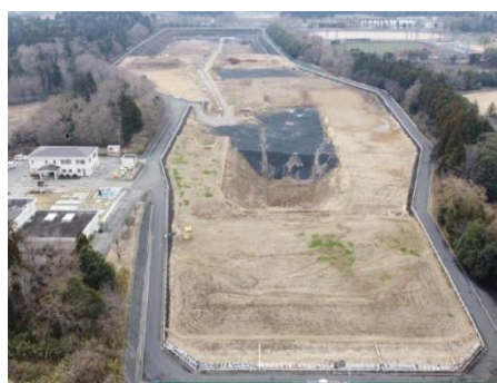
[ 新内陸最終処分場の全景 ]
