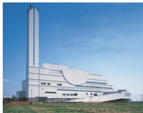
〔新港清掃工場の全景〕
