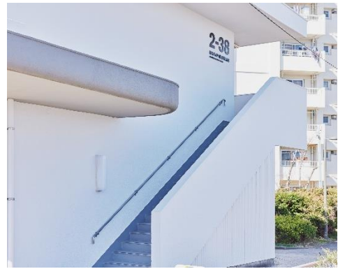
商店街施設棟の外壁
