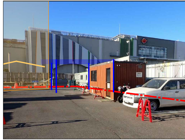
現況写真H
