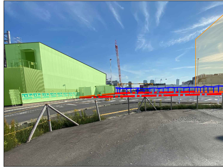
現況写真B
