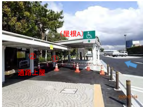
バリアフリー施工後写真
