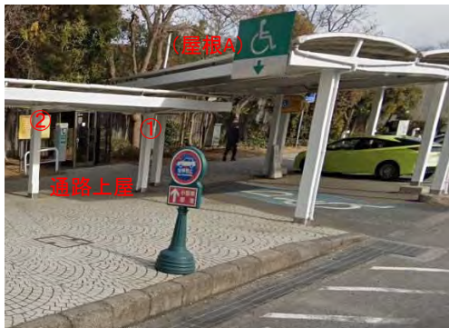
バリアフリー施工前写真
