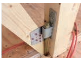
接合部の補強
