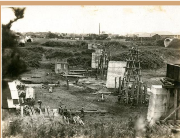
架橋作業 全景
