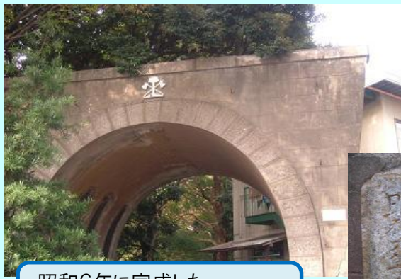
昭和6年に完成した 事務所脇の演習用トンネル
