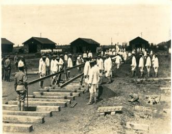
レールの敷設作業（左）と架橋訓練（右）
