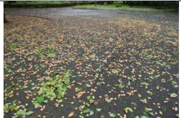
冠水した道路
