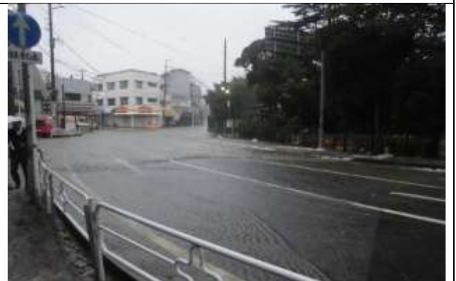
冠水した道路
