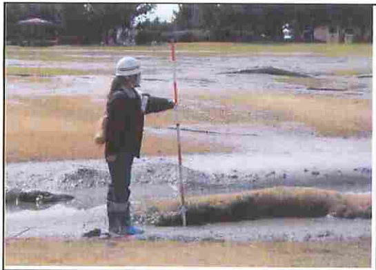
芝生広場(液状化による地面の隆起)
