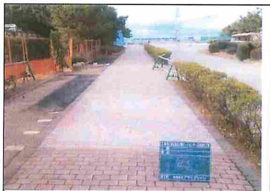
噴出土砂除去後、AS舗装打ち替え インターロッキングブロック、縁石の据え直し
