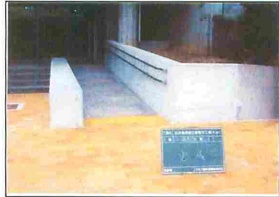
コンクリート擁壁打ち直し後
