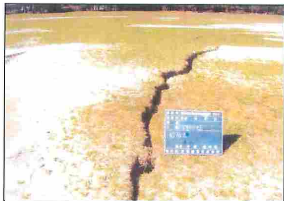
芝生広場(亀裂)
