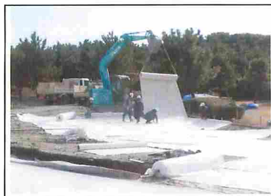
池底全体にベントナイトを含む防水シートを布設し その上に保護層としてコンクリートを打設した
