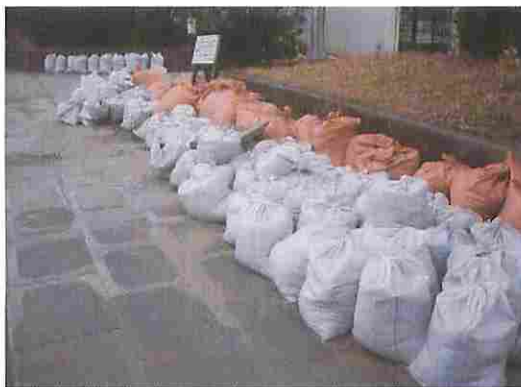
真砂第2公園 公園周辺の噴出土砂仮置場として公園を利用
