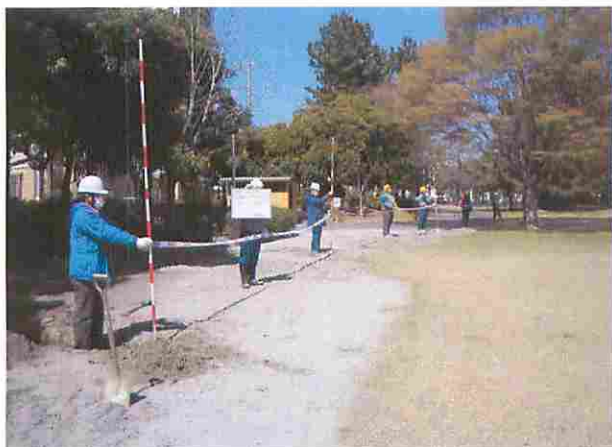
浜田公園 復旧が必要な箇所はすべて計測
